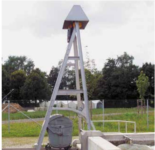
*Beim HUBER Korbrechen CageLift ist die elektro-mechanische Aushebevorrichtung oberhalb des Kanals bzw. des Pumpenschachtes angebracht, so dass der Rechengutabwurf direkt in einen Container erfolgen kann.*
