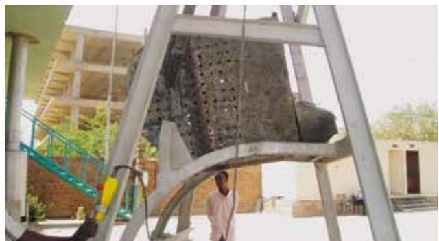
*Die Führungsbahnen sind beim HUBER Korbrechen CageLift im oberen Abwurfbereich kurvenförmig ausgeführt, so dass der gefüllte Rechenkorb direkt über einen Container gefahren werden kann und sich teilautomatisiert entleeren lässt.*
