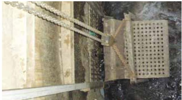
*Zuverlässige und sichere Führung des Rechenkorb durch beidseitig angeordnete Führungsbahnen.*
