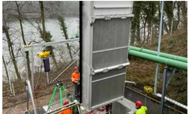
Einbau eines RakeMax® bei einer Anlagenmodernisierung.
