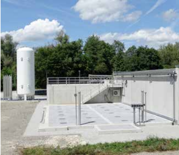
24 HUBER Aktivkohlefilter CONTIFLOW® GAK mit vorgeschalteter Ozonung.
