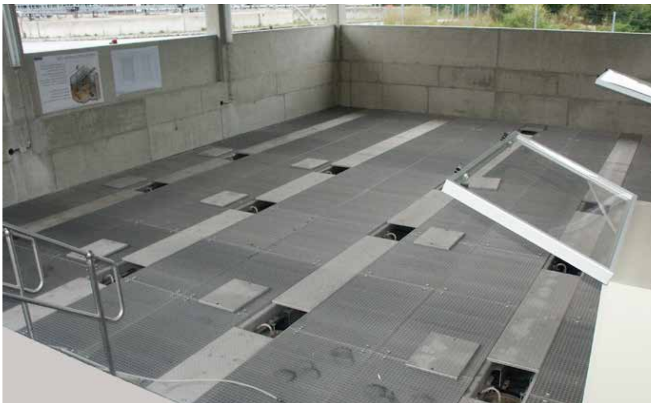
HUBER Aktivkohlefilter CONTIFLOW® GAK (Beckenversion).
