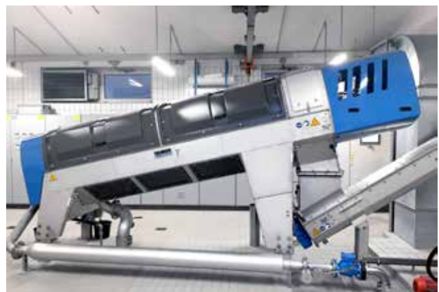
Faulschlamm-entwässerung bis zu 30 % TR.
