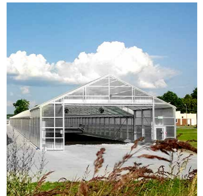
Tore zum Einbringen von entwässertem Schlamm.
