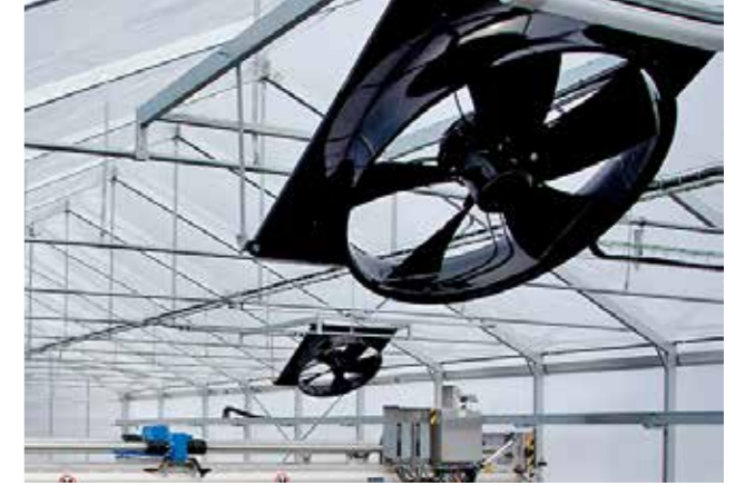
Umluftventilatoren sorgen für verbesserte Verdunstung.
