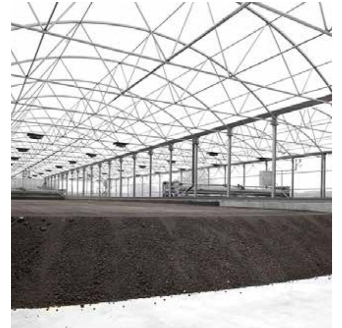
Trockenschlamm zum Abtransport mit Radlader und Lastwagen.
