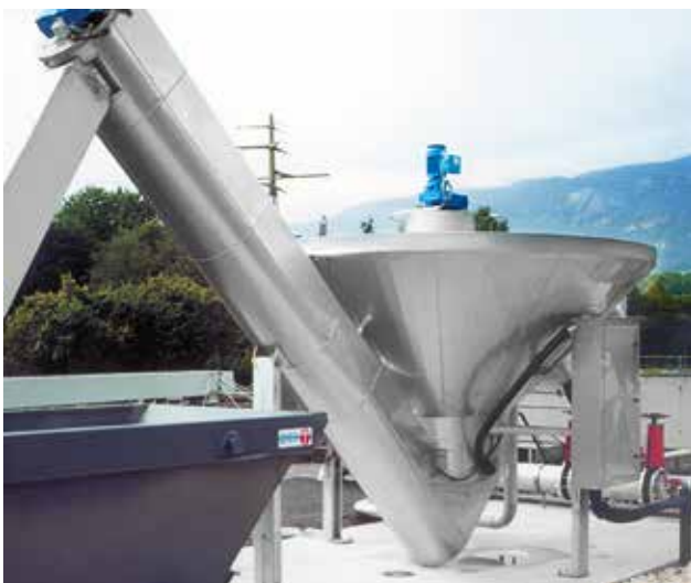
Innovative Technik: HUBER Coanda Sandwaschanlage RoSF4 3, beheizte Ausführung für den Betrieb im Freien.
