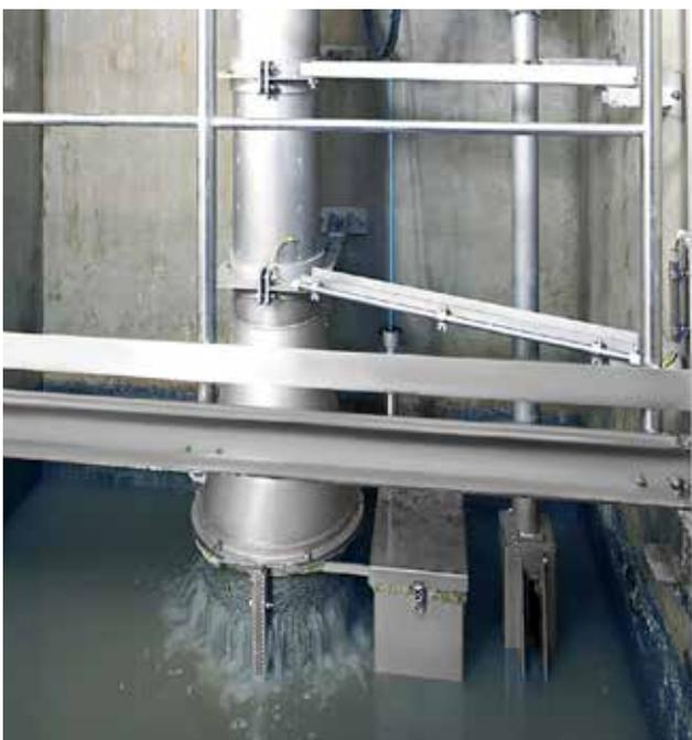
Vorsiebung im Entnahmebauwerk mittels einer HUBER Schachtsiebzanlage ROTAMAT® RoK4.
