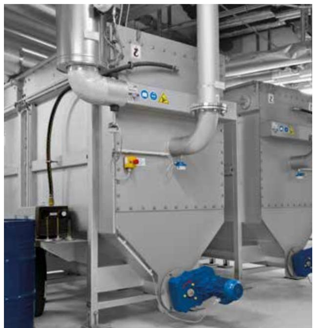
Kommunales Abwasser; 2x RoWin BG8; therm. Entzugsleistung 560 kW Heizen / 1.000 kW Kühlen.
