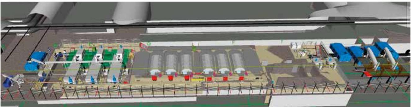
Abbildung 4: Anwendung River & Sea outfall mit 6 x HUBER Trommelsieb LIQUID als Vorklärbeckenersatz.
