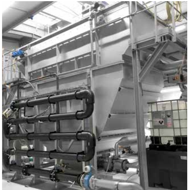
HUBER Druckentspannungsflotationen mit chemischer Vorbehandlung – Voll-, Teil- oder Nachreinigung industrieller Abwässer.
