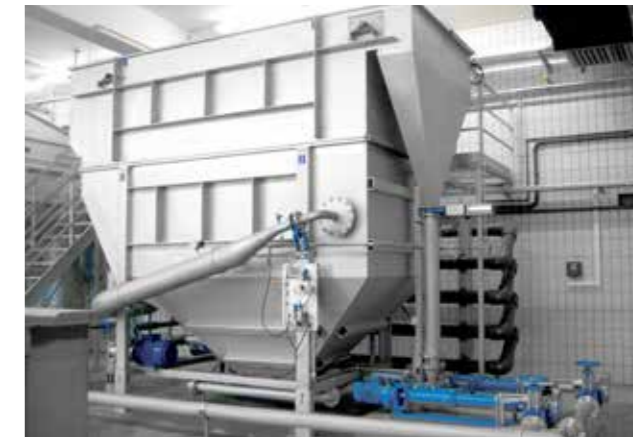
HUBER Druckentspannungsflotation zur physikalisch-chemischen Vorreinigung – optimale Reduktion von CSB, Fetten und Feststoffen, mehr als 500 Installationen weltweit.
