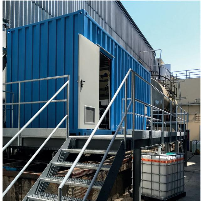
Containeranlage HUBER Druckentspannungsflotation HDF S2
