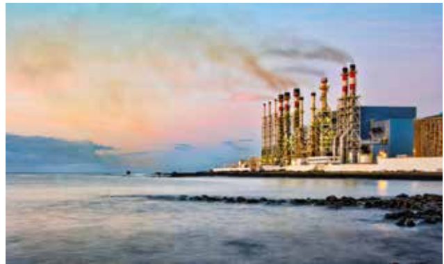
Entsalzungsanlage in Arrecife auf Lanzarote.
