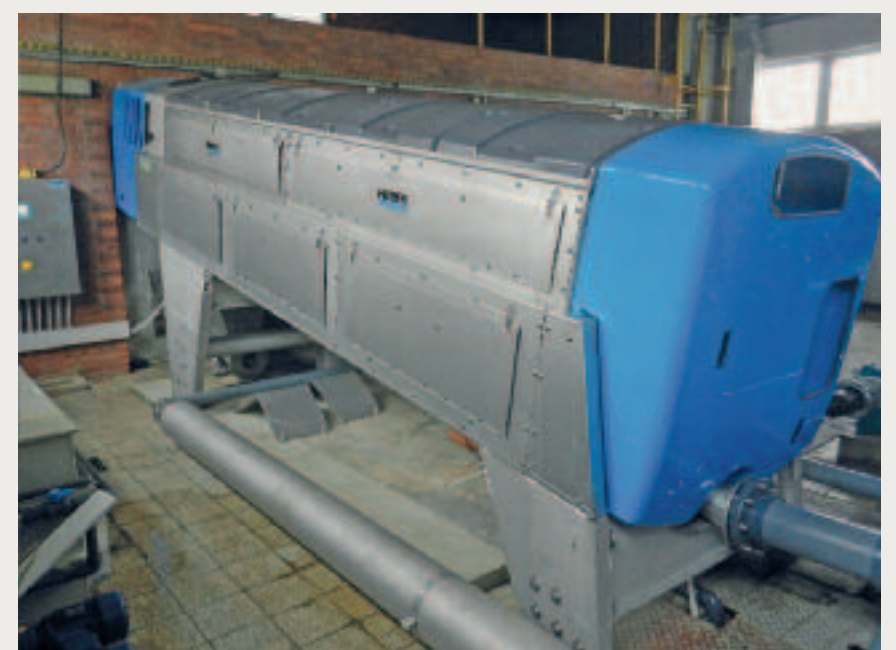
Die neue HUBER Schneckenpresse Q-PRESS 800.2 seit Oktober 2017 erfolgreich in Betrieb auf der KA Zawiercie
