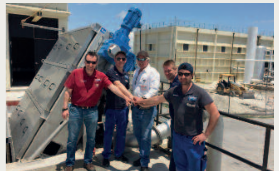
Abbildung 5: HUBER Servicetechniker zusammen mit Betreiber Mark Mc. Namera auf der Kläranlage Miami, USA
