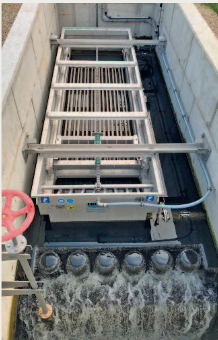
HUBER Abwasserwärmetaucher RoWin in Betonbeckenausführung
