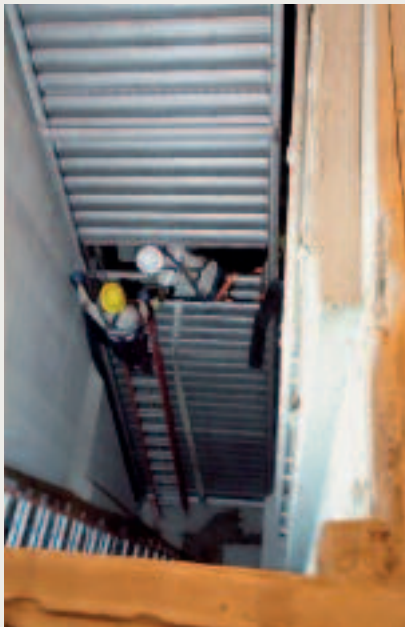
Montagephase der 12 m langen HUBER Lochblech-Umlaufrechen EscaMax®
