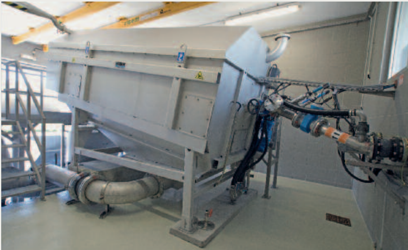
HUBER Fäkalannahmestation RoFAS mit integrierter Leitfähigkeitsmessung in Ljubljana
