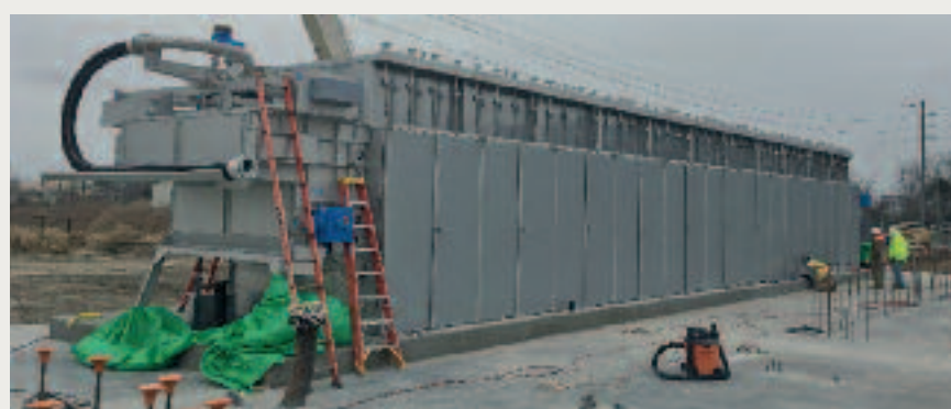
Abbildung 1: HUBER Bandrockner BT 22 während der Montage
