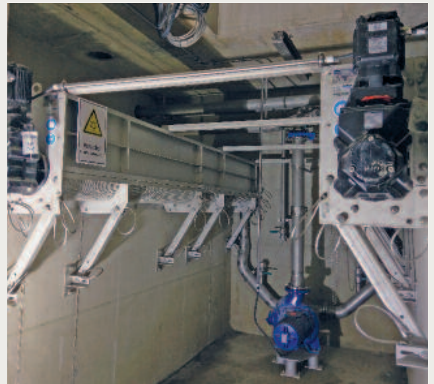
Abbildung 1: HUBER Lösung in Castrop-Rauxel – HUBER Siebanlagen ROTAMAT® RoK1 mit Pumpen zur Rechengutrückführung
