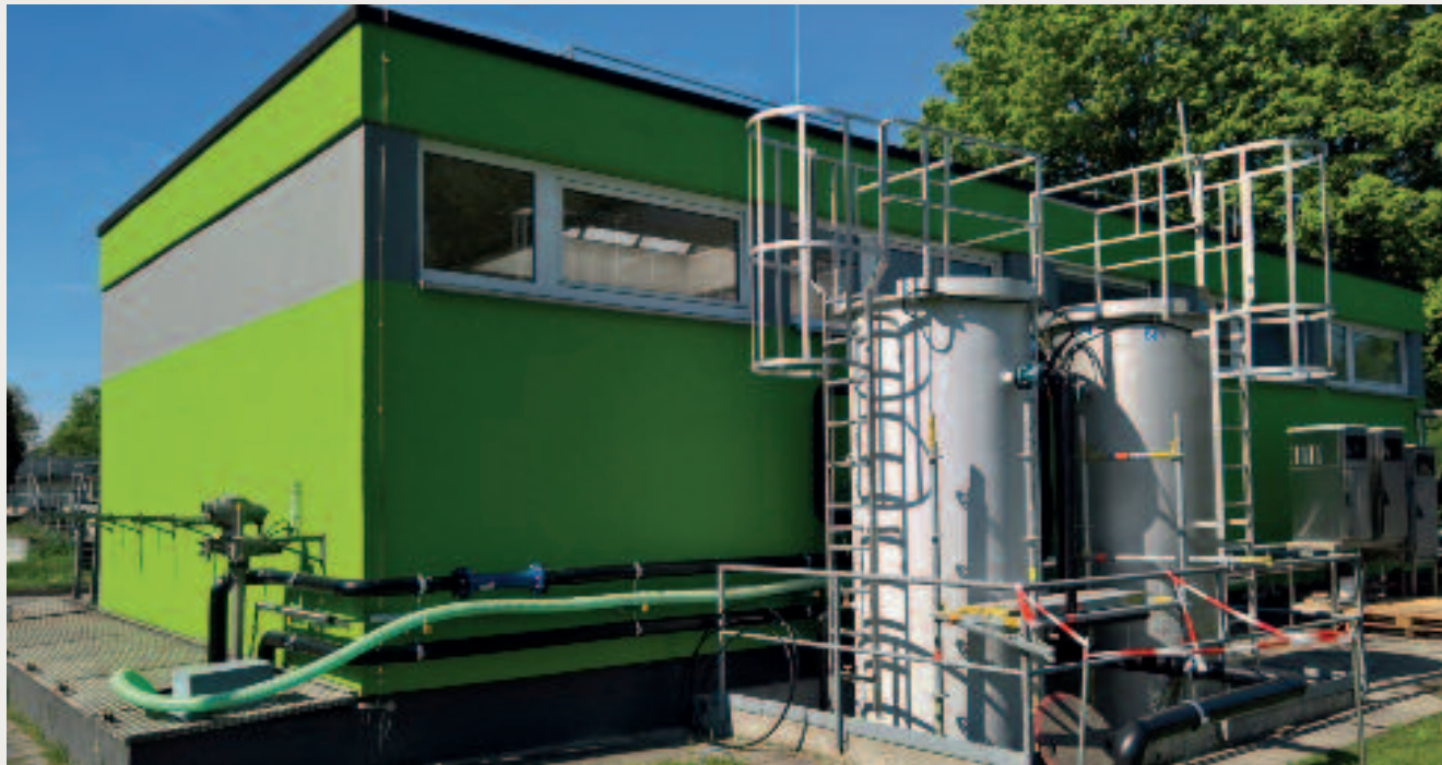
Aktivkohlefiltration auf der ZABA bei Boehringer Ingelheim – zwei HUBER Aktivkohlefilter CONTIFLOW® GAK
