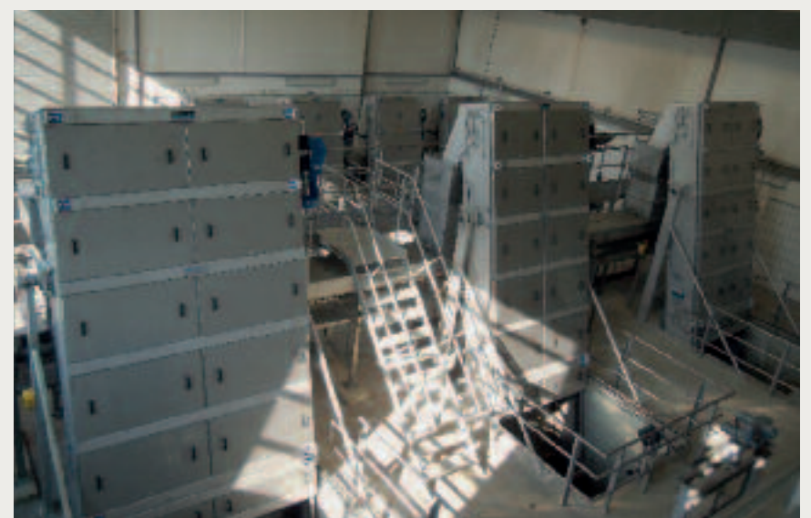
Gesamtübersicht 3 RakeMax® als Grobrechen, 4 RakeMax® als Feinrechen
