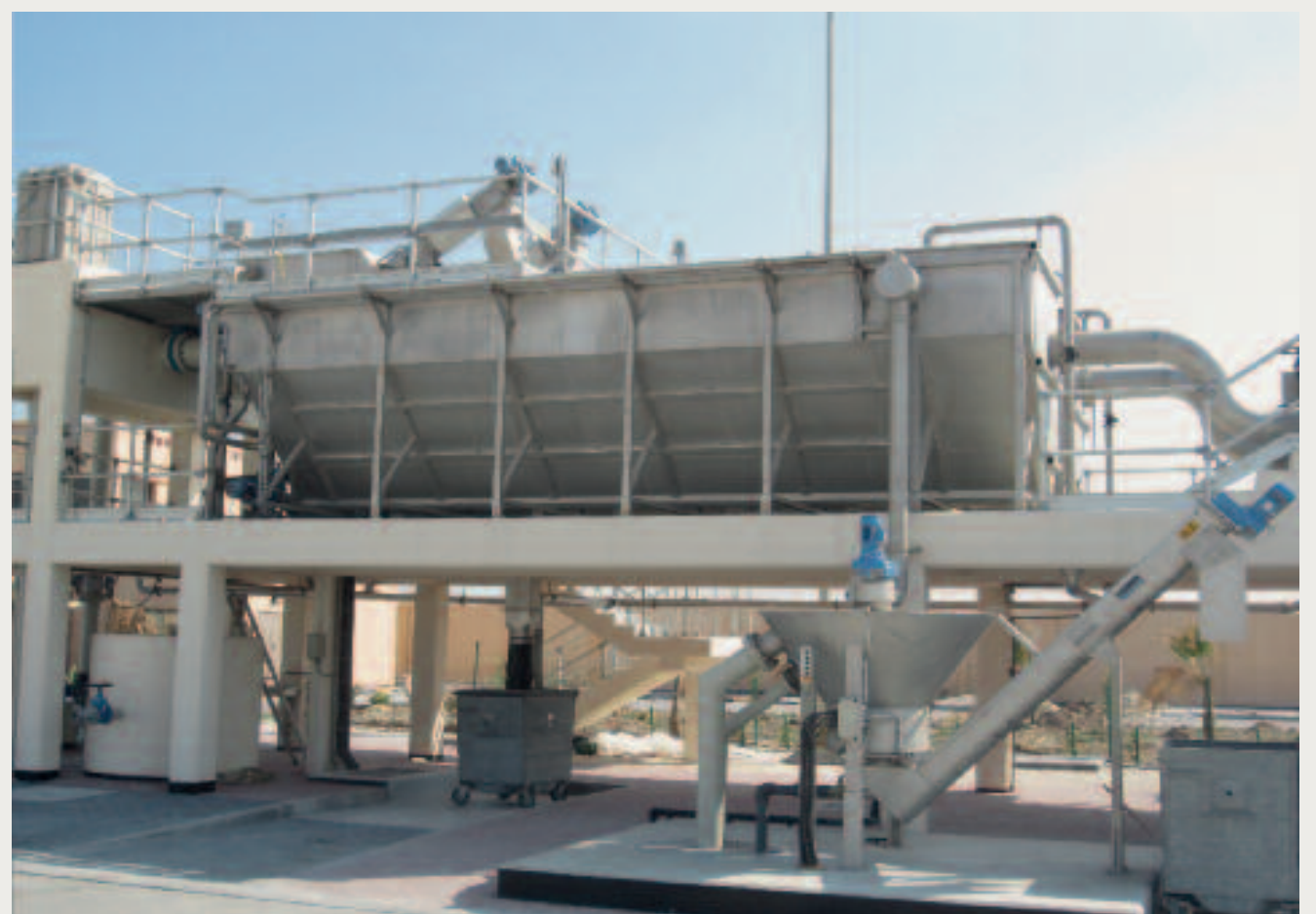
HUBER Langsandfang ROTAMAT® Ro6 mit nachfolgender HUBER Coanda Sandwaschanlage RoSF4
