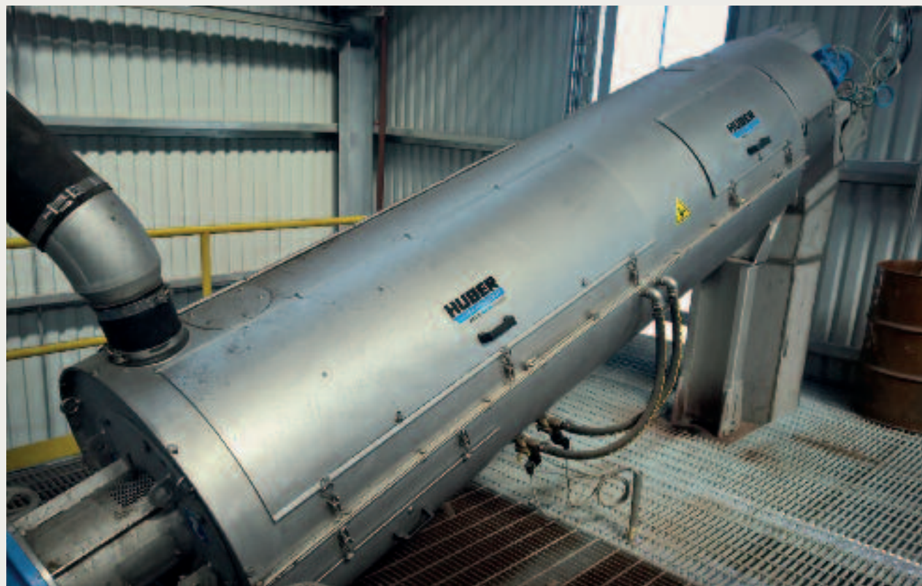
HUBER Schneckenpresse S-PRESS, zur Abwassersiebung und Vorentfrachtung des feststoffreichen Abwassers
