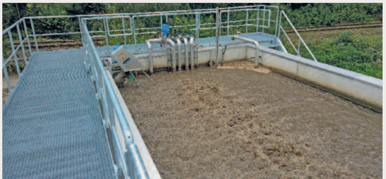
Gleichmäßiges Spülluftbild und niedrige Spülluftmenge charakterisieren die neue HUBER Membranfiltration VRM®
