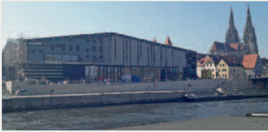
Abbildung 2: Baufortschritt des Museums in Regensburg
