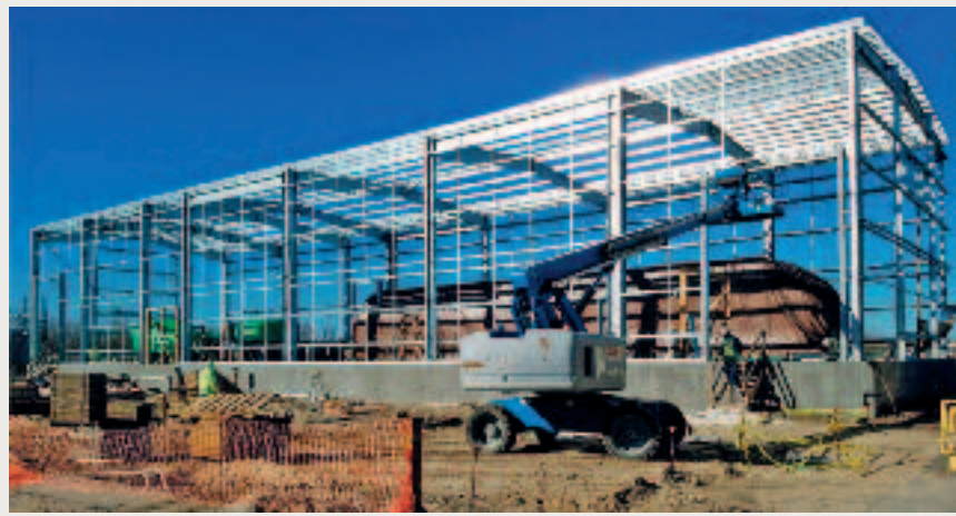
Abbildung 2: Bau des Gebäudes für die Klärschlammbehandlung Savannah
