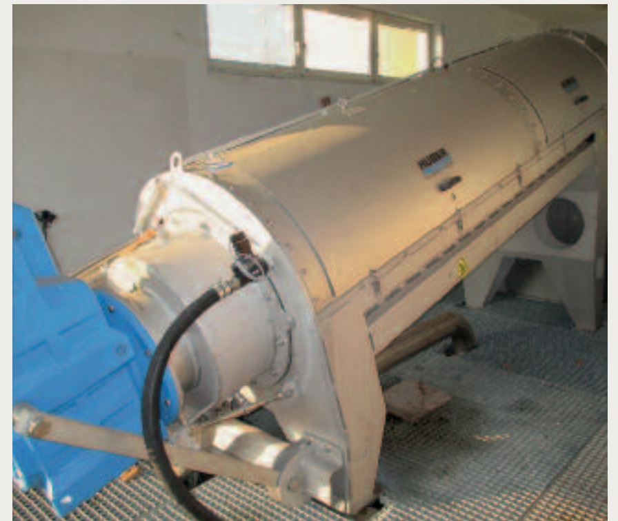
Die neu installierte HUBER Schneckenpresse Q-PRESS® 620.
