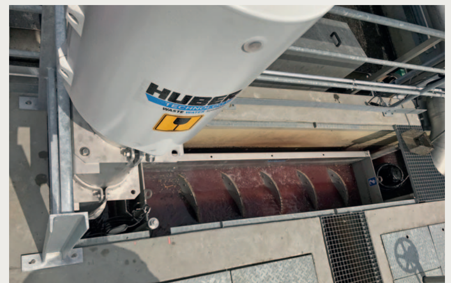
Die Siebanlage ROTAMAT® RoK4 kann ab Gerinne-OK mittels 4 Schrauben gelöst werden
