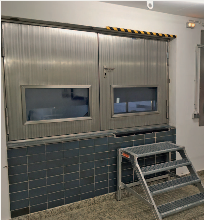
HUBER Wasserkammertür mit optionalem Glasausschnitt für Besuchergruppen, Aufbereitung Dreis-Tiefenbach des Wasserverbands Siegen-Wittgenstein
