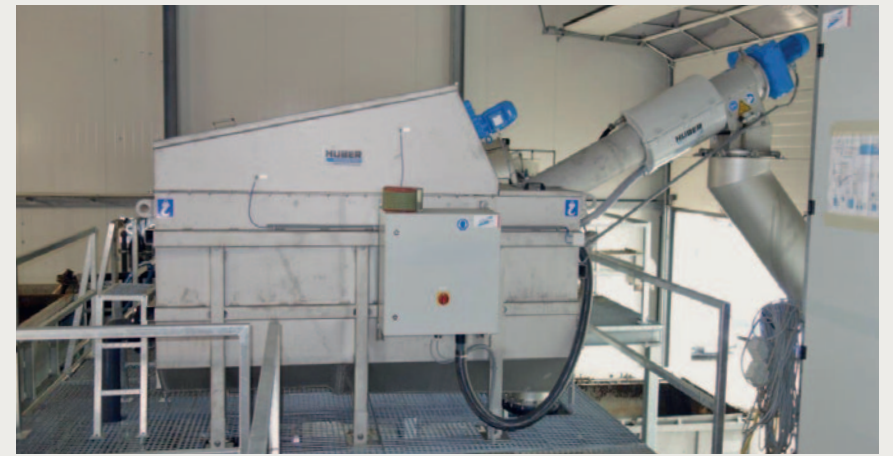
HUBER ROTAMAT® Siebanlage RPPS 1000 mit drehbarem Abwurf
