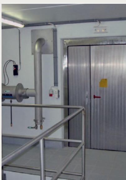
HUBER liefert alles aus Edelstahl: Sicherheitstür, Geländer und Luftfilteranlage
