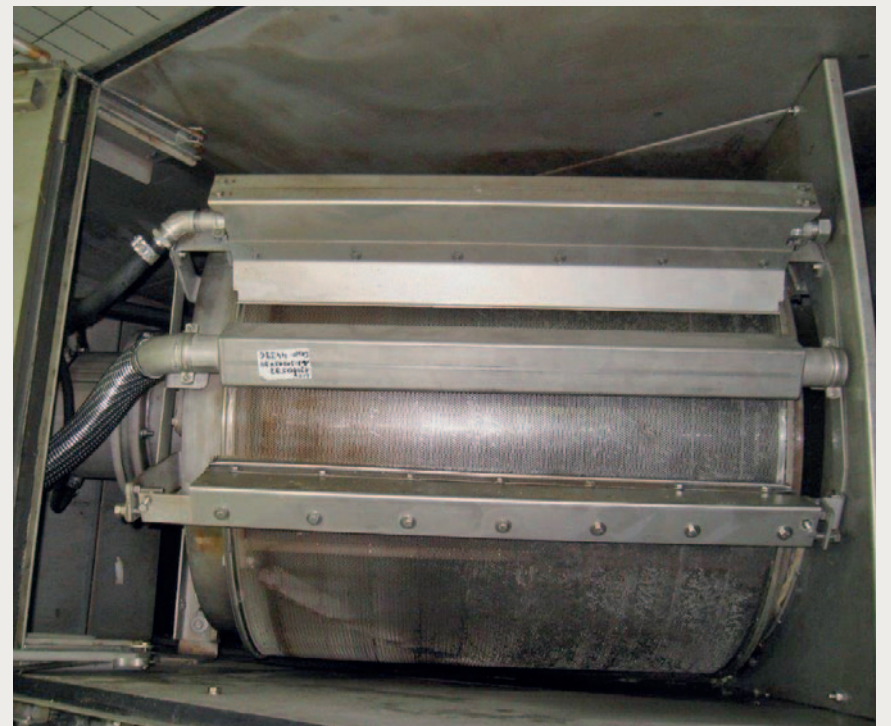
Blick auf den Siebkorb einer HUBER ROTAMAT® Siebanlage ausgestattet mit einer Luftklinge und einer traditionellen Spritzdüsenleiste
