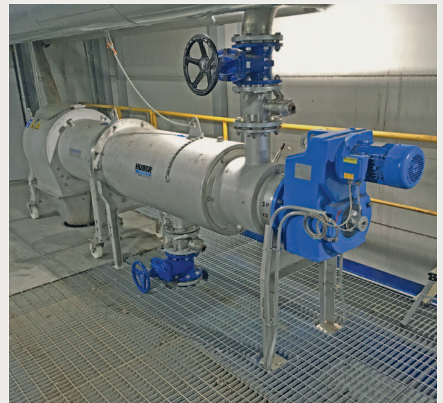
STRAINPRESS® 430 mit 10 mm Perforation zur Grobstoffentfernung vor Regelventilen und Dekantern in der Zellstoffindustrie
