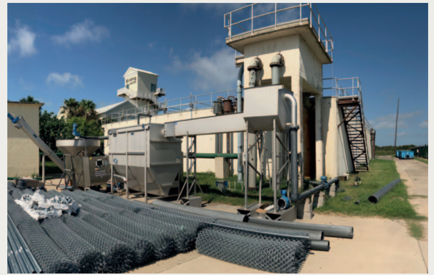
Teststand zur Ermittlung der Abscheideleistung des HUBER Sandfanges GritWolf® bei 40°C in South Padre Island, TX
