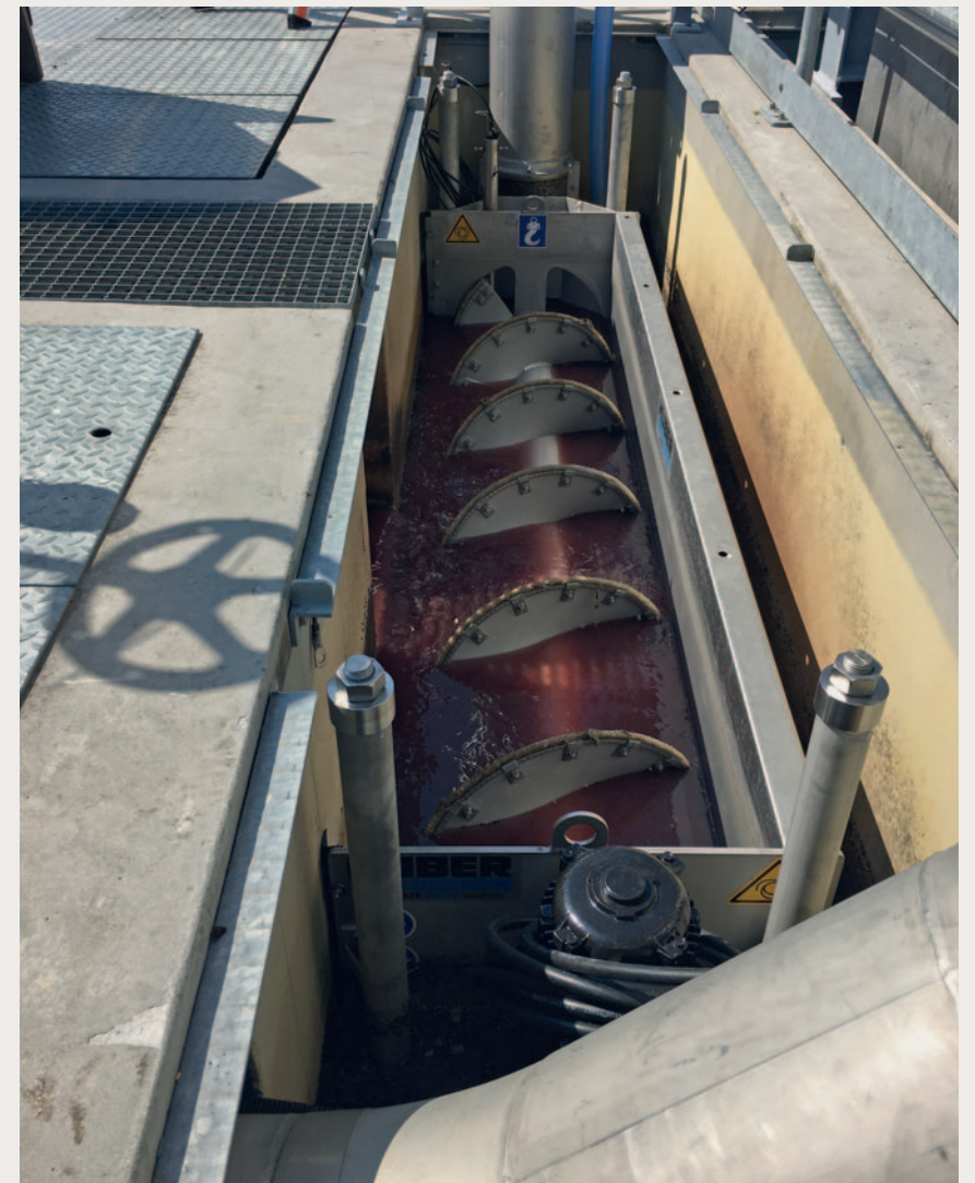
3 mm Lochsiebung inkl. Rechengutbehandlung auf engstem Platz.
