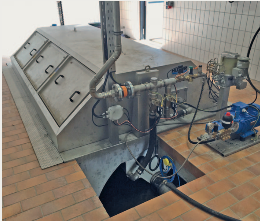
KA Vohburg - HUBER Trommelsieb LIQUID als Alternative zum Vorklärbecken für 360 m³/h auf geringstem Bauraum
