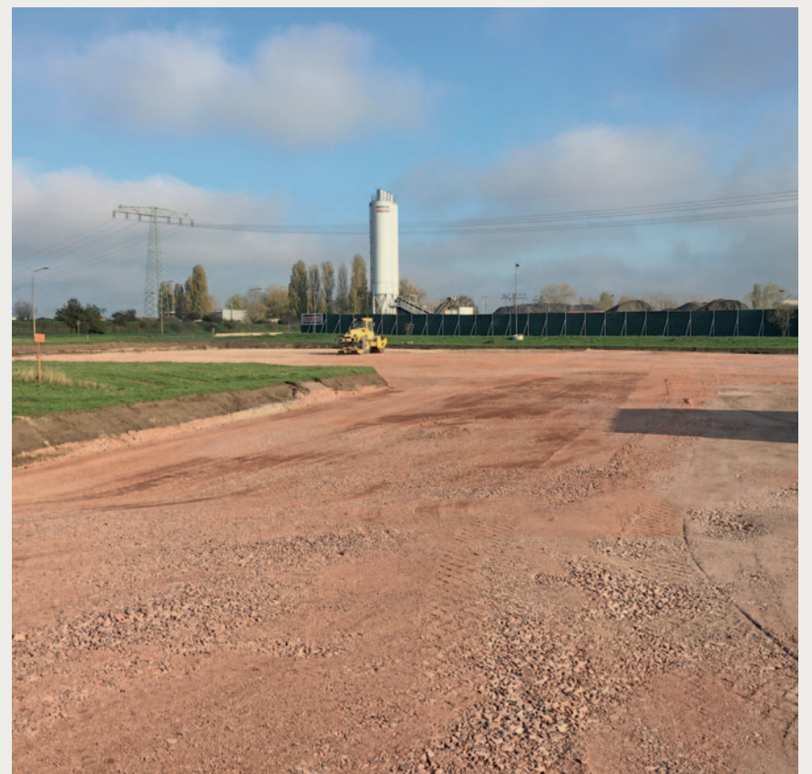
Baufeldvorbereitung Ende Oktober
