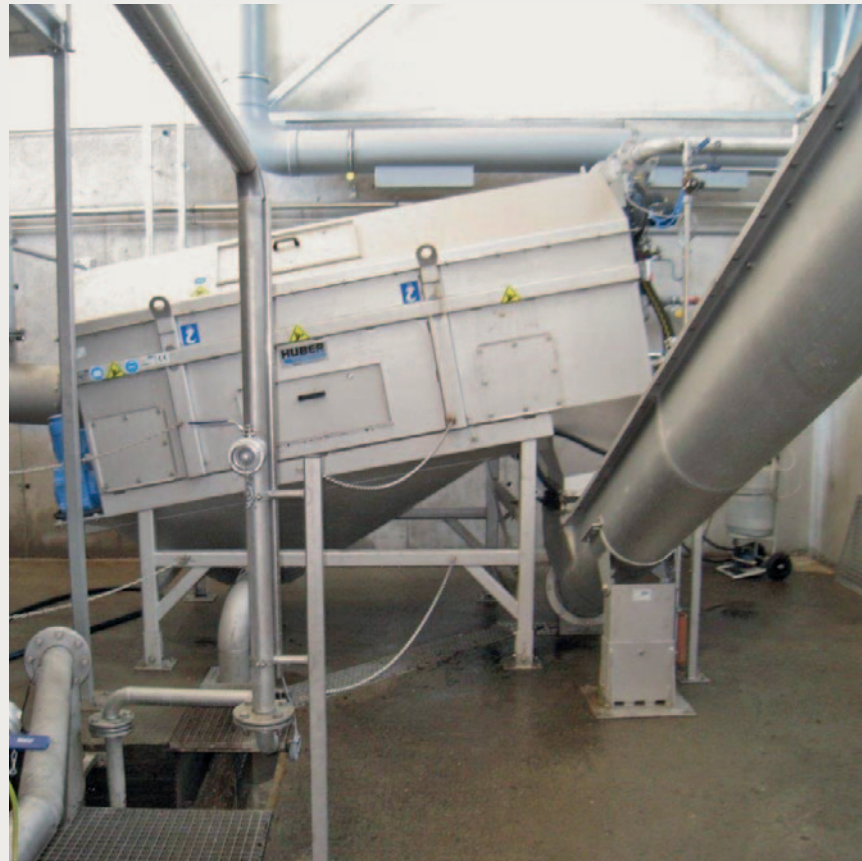
Grobstofftrennung und Auswaschung feiner Bestandteile mittels HUBER Waschtrommel RoSF9
