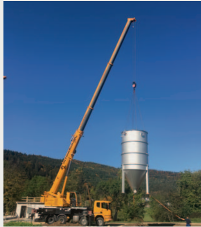
Der HUBER Aktivkohlefilter CONTIFLOW® GAK wird angeliefert
