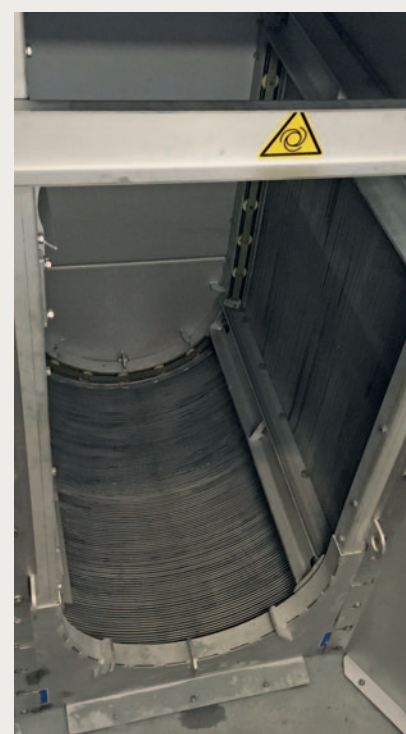
Durch den U-förmigen Rechenrost des RakeMax® CF wird ein Plus an hydraulischer Durchsatzleistung erreicht
