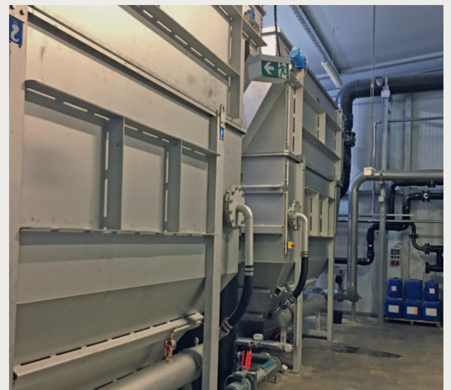
Zweimal HUBER Druckentspannungsflotation HDF
