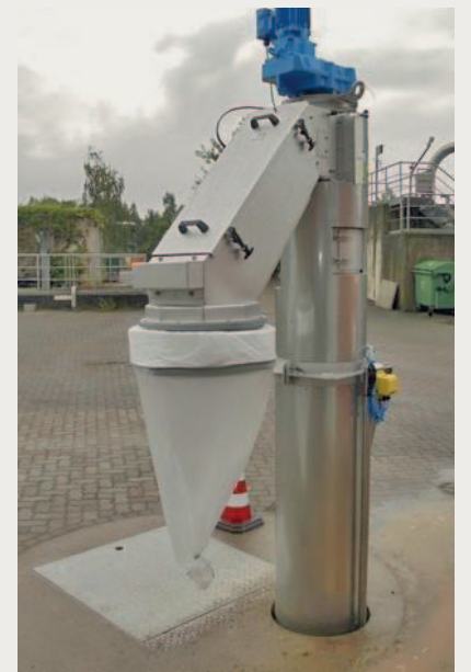
Nachgerüstete HUBER Schachtsieb- anlage ROTAMAT® RoK4 zur Abscheidung von Makroplastik aus Filtrat- abwasser einer Schlammverdickung
