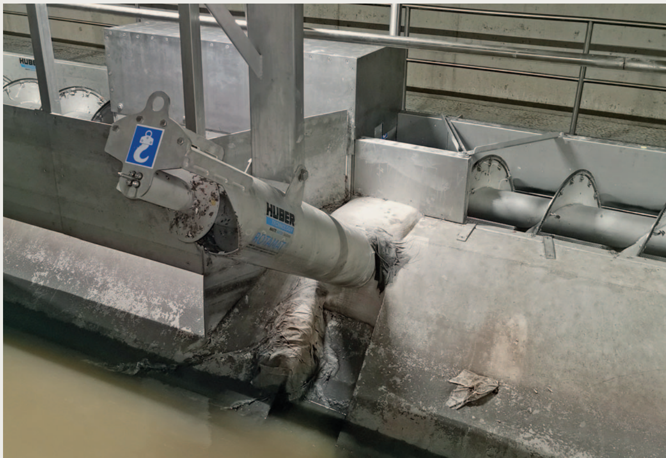
Kombination aus zwei Maschinen – Die HUBER Siebanlage ROTAMAT® RoK1 TS mit angeflanschter Transportschnecke für einen sicheren Abtransport von Siebgut
