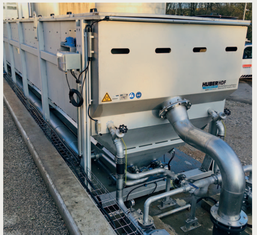
Außenaufstellung einer HUBER Druckentspannungsflotation HDF S 8 als Alternative zur Nachklärung
