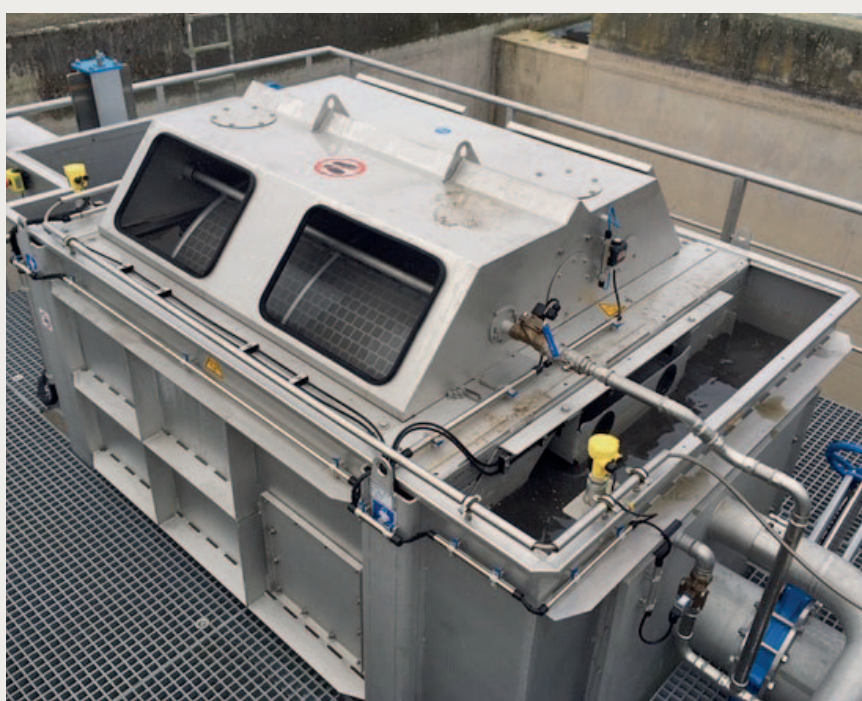
KA Kahla - Kompaktes Trommelsieb LIQUID System für max. Reduktionsleistungen AFS / CSB
