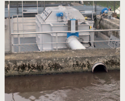
KA Kahla - HUBER Trommelsieb LIQUID als Vorklärbeckenersatz in einem stillgelegten Betonbecken installiert
