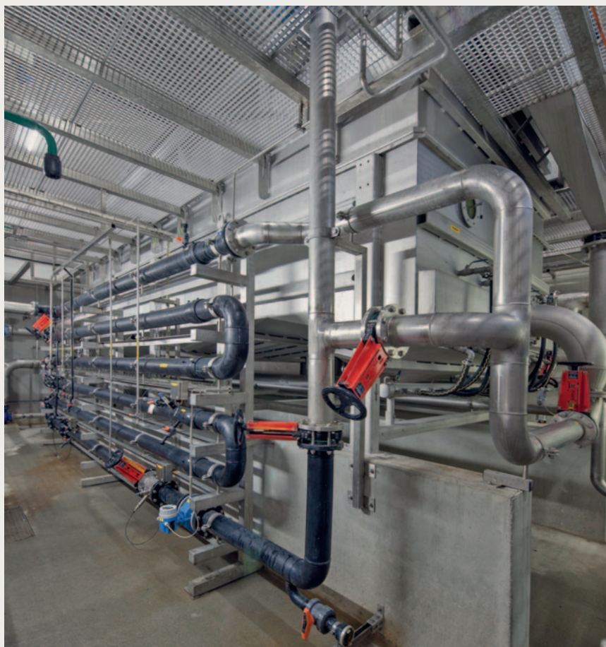
Die chemische Stufe der HUBER Druckentspannungsflotationen HDF
