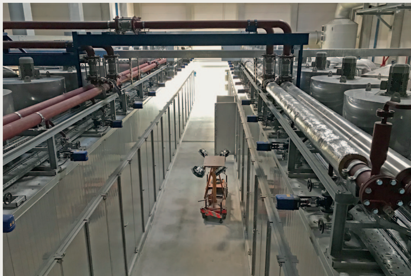
Die Montagearbeiten kurz vor der Fertigstellung
