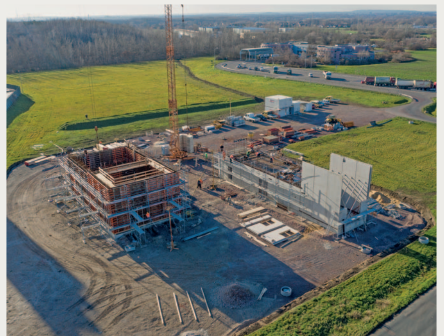
Luftaufnahme der Baustelle Ende Januar 2020
