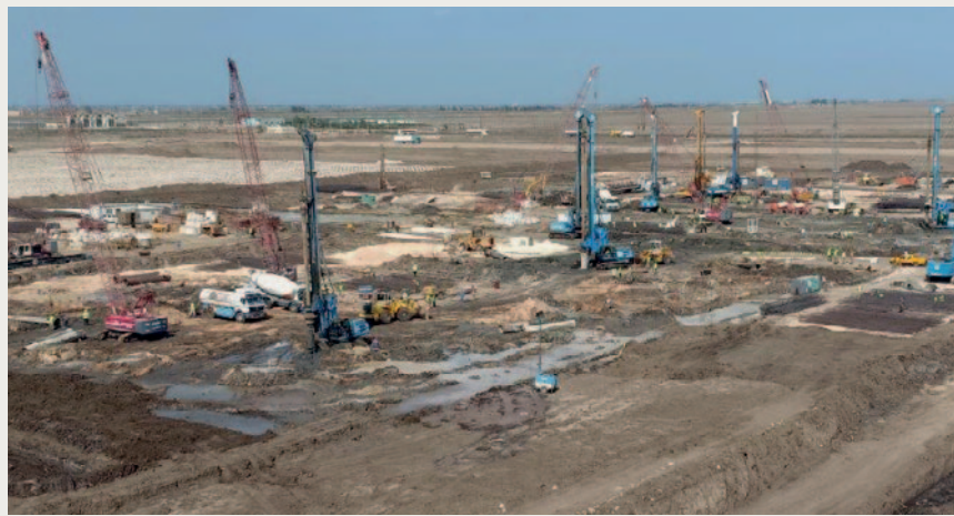
Auf der Baustelle der Kläranlage Bahr El-Baqar waren zu Beginn der Bauphase im Herbst/Winter 2019 bereits 1.500 Arbeitskräfte aktiv.
