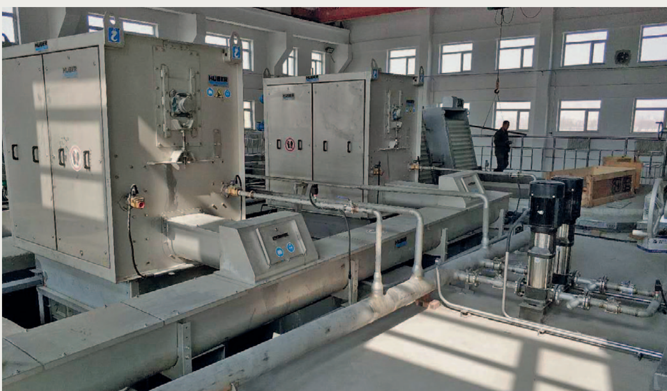
Shuangliao. 1530 m³/h pro Rechen für max. Abscheideleistungen zum Schutz nachgeschalteter Membrananlagen
