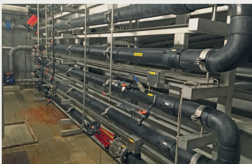
Der Röhrenflokulator der HUBER Druckentspannungsflotationen HDF
