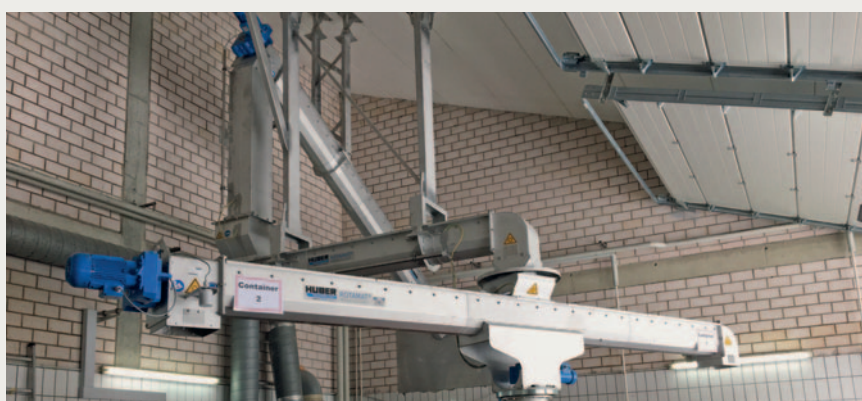
HUBER Fördertechnik Ro8T für die automatische Verteilung und Befüllung der Schlammcontainer
