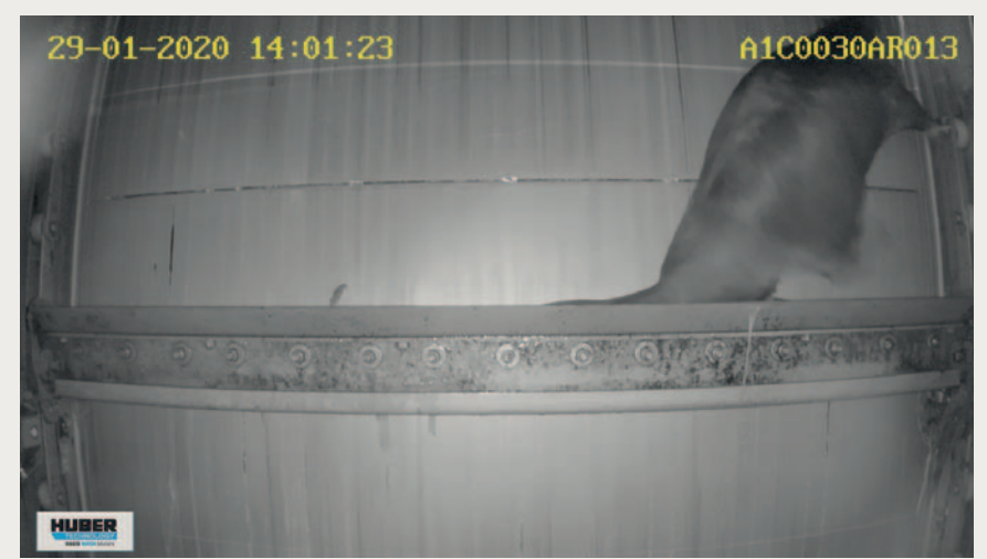
Der Blick ins System zeigte an der Leitwarte einen Biber auf dem Räum balken
