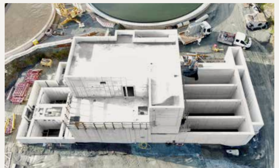
Der Neubau der Vierten Reinigungsstufe in Bickenbach schreitet zügig voran. Quelle: Jörg Stanzel, AV Bickenbach.
