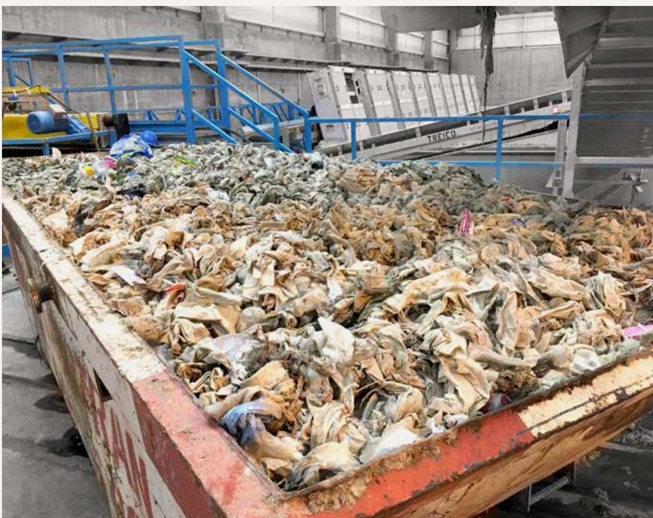
Container voller erfolgreich abgeschiedenem Rechengut: Ende 2021 waren die Anlagen in Butarque vollständig modernisiert und betriebsbereit.
