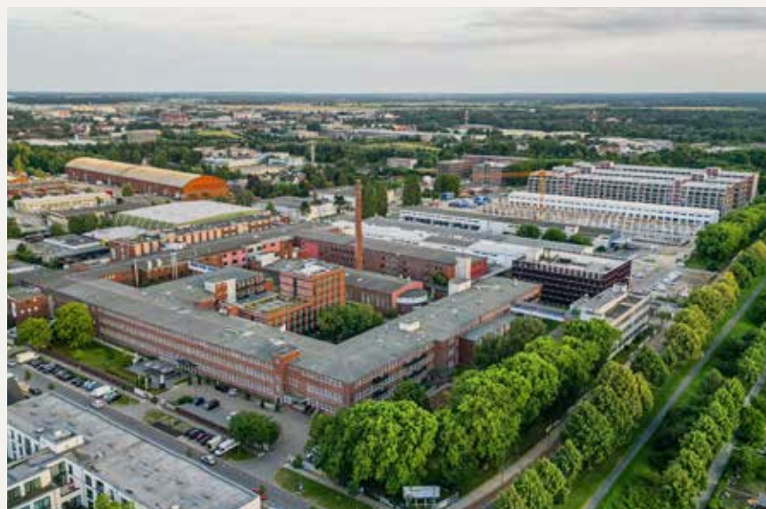
Bis 2026 entsteht in Bremen das neue „Tabakquartier“, gefördert durch die Bundesförderung für effiziente Wärmenetze. (© Justus Grosse Immobilienunternehmen)
