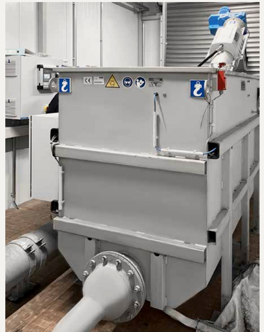
Auch in der Holzindustrie kommt die HUBER Siebanlage ROTAMAT® Ro2 mit Luftklinge zum Einsatz. Die Anlage ist komplett eingekapselt, was einen sauberen Betrieb der Maschine sicherstellt.
