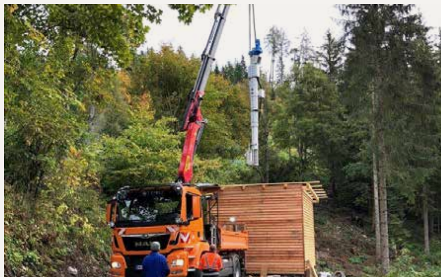
Einbau der Schachtsiebanlage am 6.10.2020.
