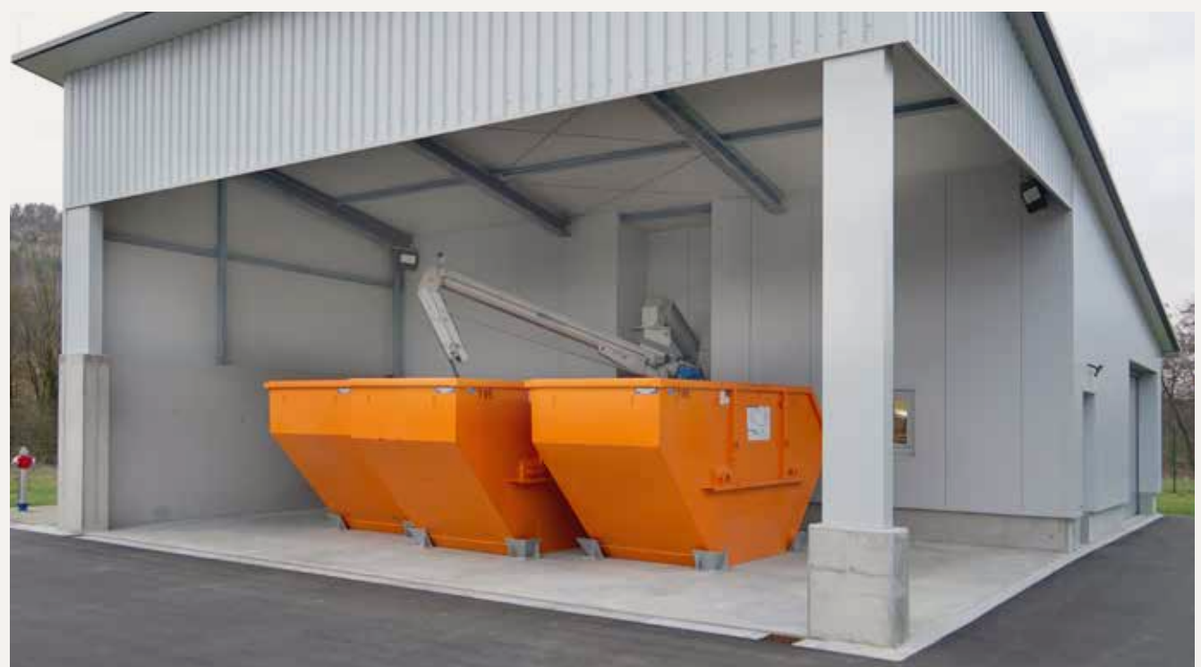
Neues Entwässerungsgebäude mit Muldenbefüllung.
