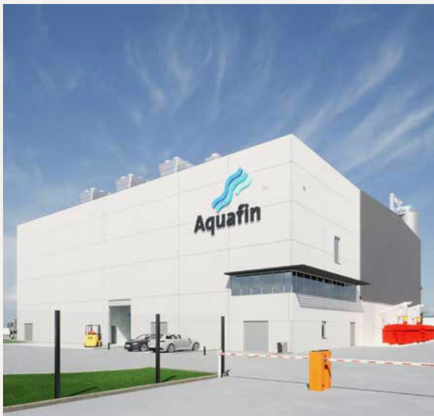
Außenansicht der Trocknungsanlage in Beringen.
