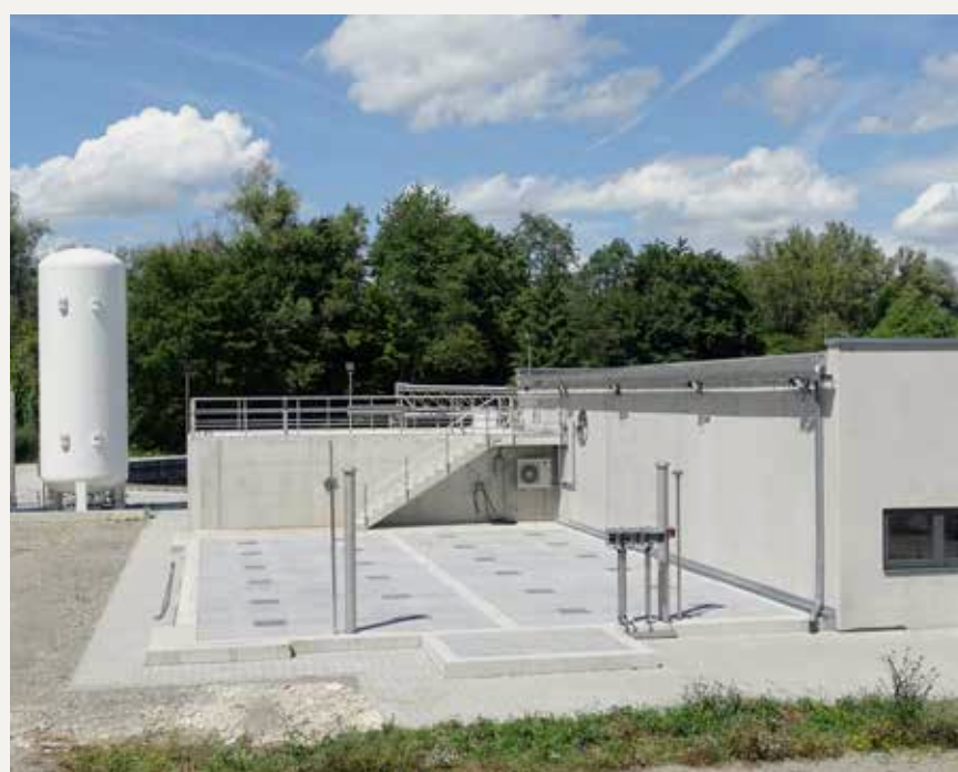
Gesamtansicht der Spurenstoffentfernung Uhldingen-Mühlhofen.
