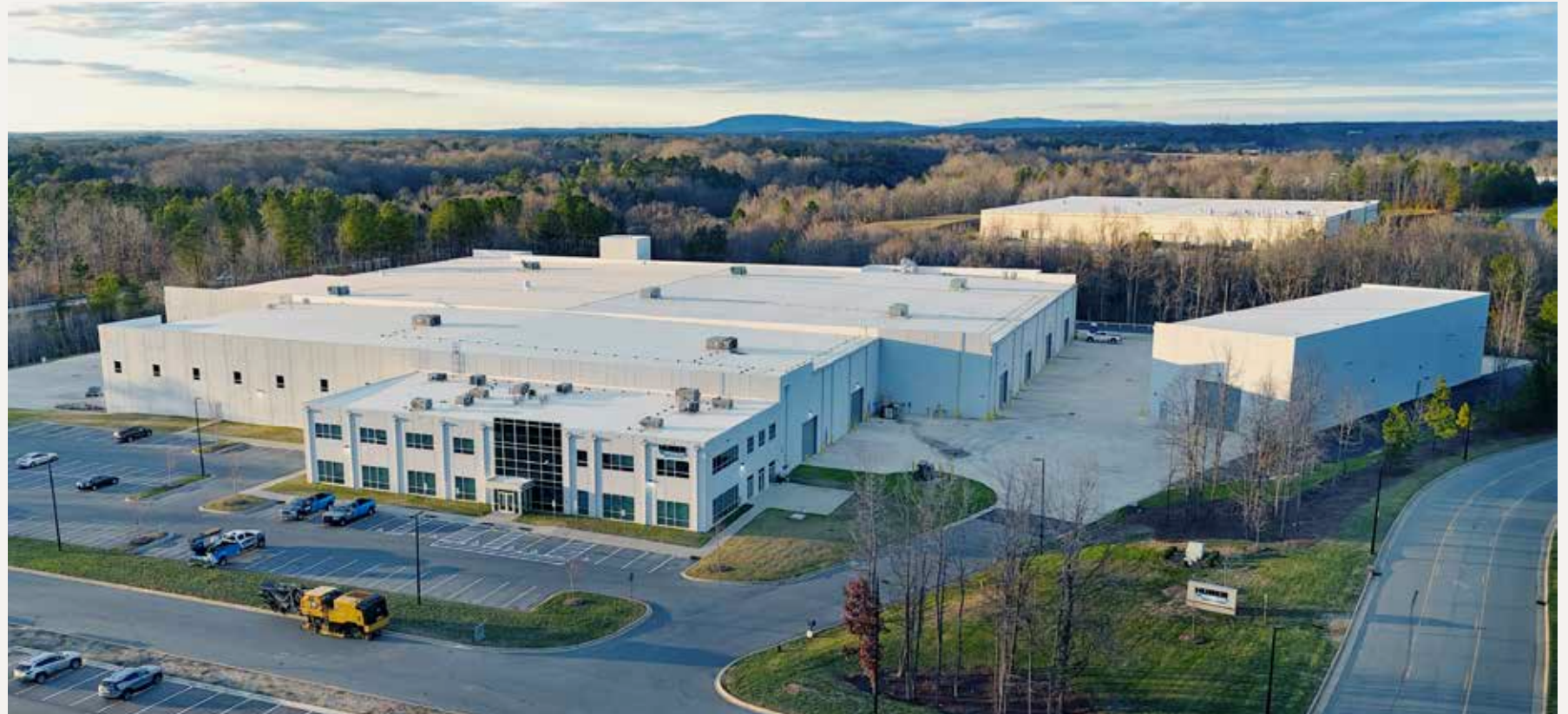
Der Standort von HUBER Technology, Inc. hat nach der Erweiterung eine Produktionsfläche von ca. 17.000 m 2 und eine eigenständige Vollbadbeizanlage.
