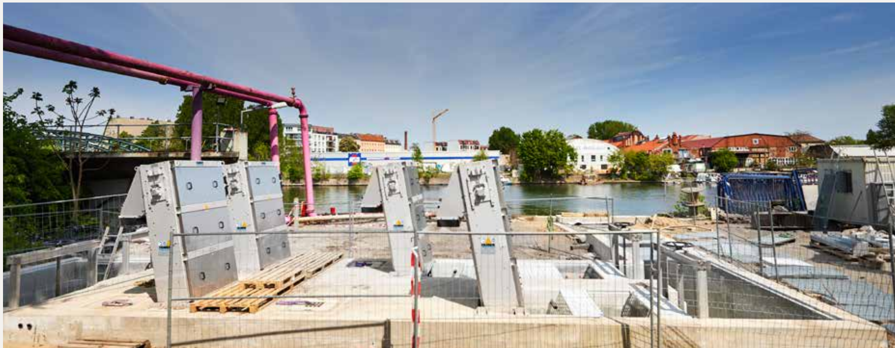
4 HUBER Harken-Umlaufrechen RakeMax® für die mechanische Reinigung im Prozess der Wärmegewinnung aus Oberflächenwasser.
