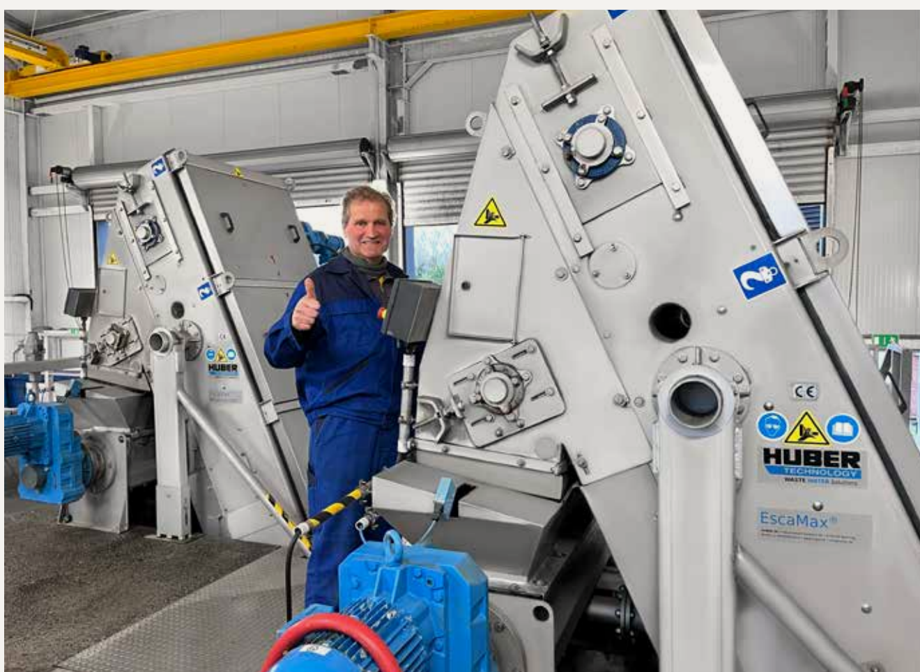
Helmut Hövel, Klärwärter der Kläranlage Ibbenbüren-Püßelbüren.
