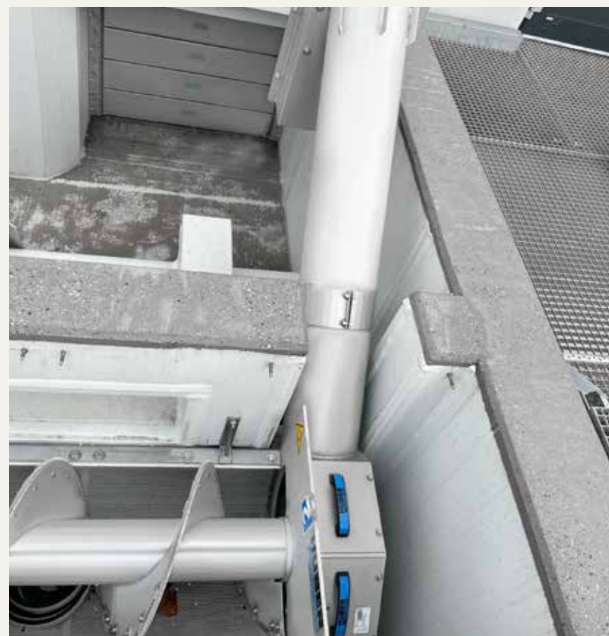
HUBER Siebanlage ROTAMAT® RoK1 TS 500/6 6250 0° in der Einbauphase.
