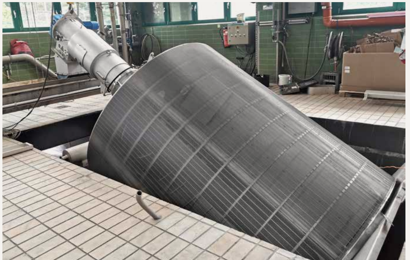
Montage einer HUBER Siebanlage ROTAMAT® Ro2 mit 2,6 m Siebkorb im Gerinne.
