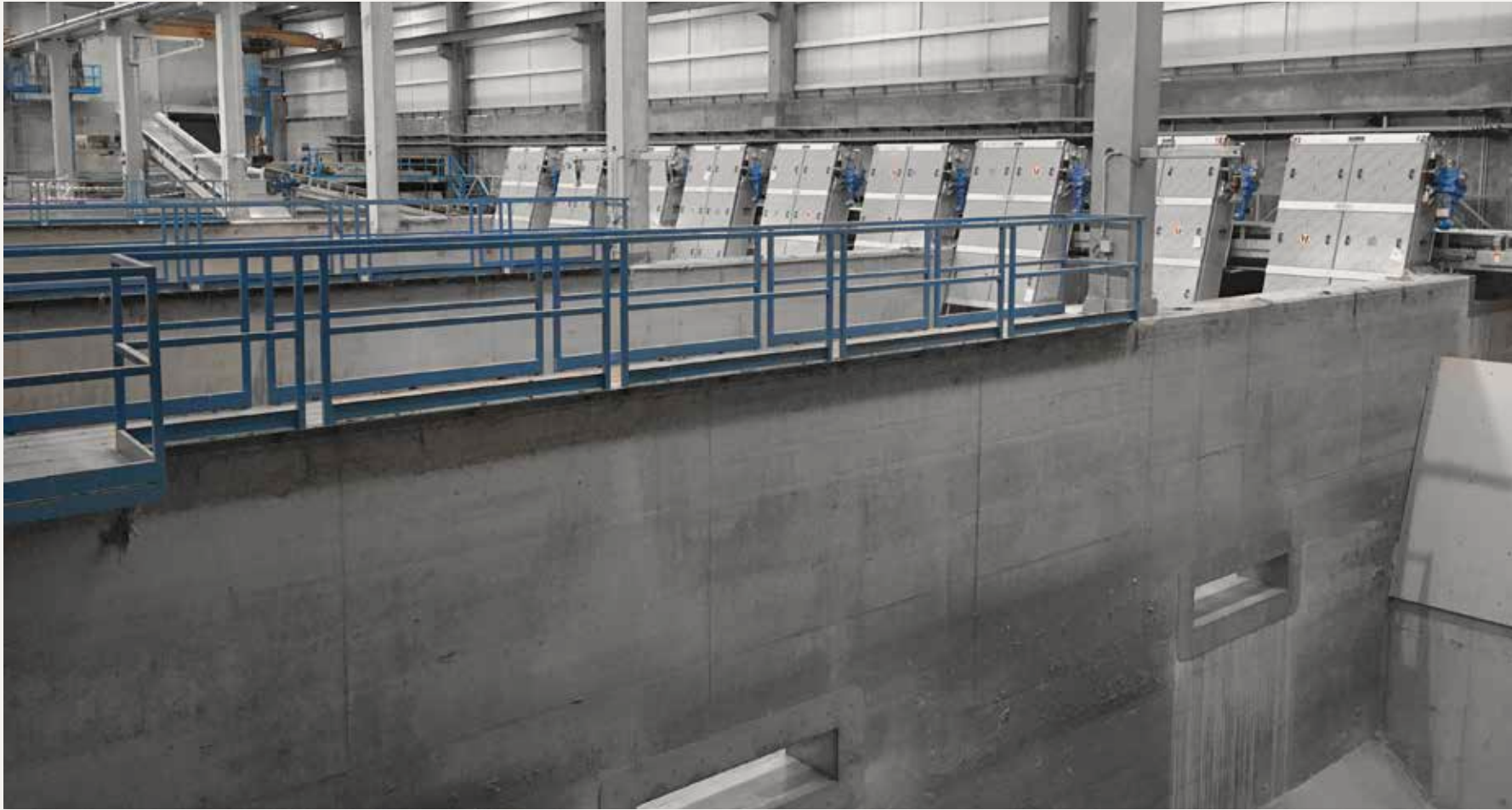
Regenbecken Butarque: 18 HUBER Harken-Umlaufrechen RakeMax® 5120 x 1775 x 40 @ 75°.
